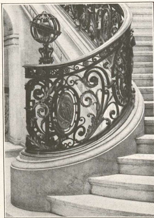
Grand escalier de la Sorbonne. Rampe de départ (côté droit).
