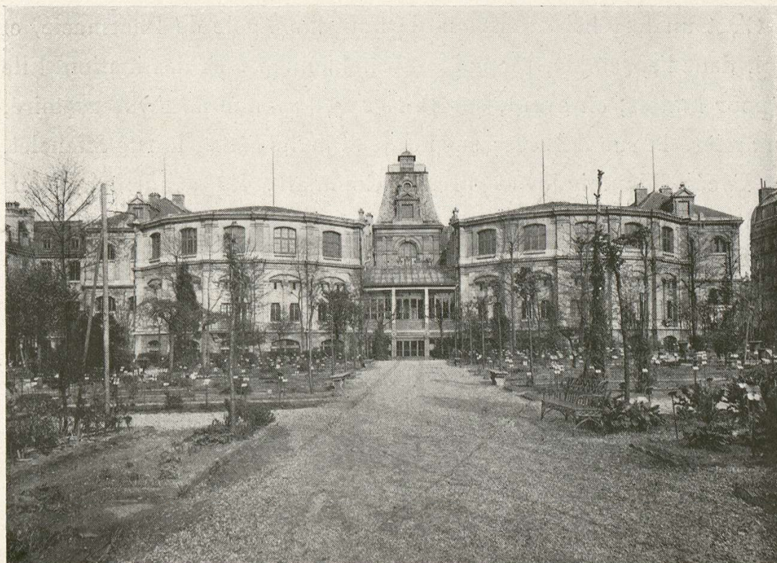
Laboratoire de chimie minérale et amphithéâtres nord et sud.
