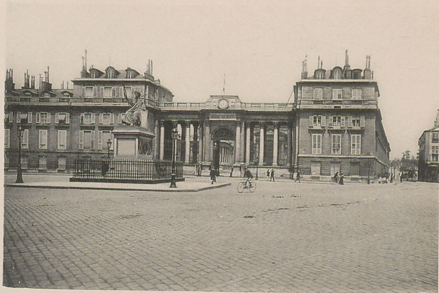
3 — CHAMBRE DES DÉPUTÉS - Entrée sur la Place du Palais-Bourbon
